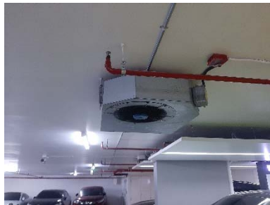
พัดลมระบายอากาศชั้นจอดรถ
