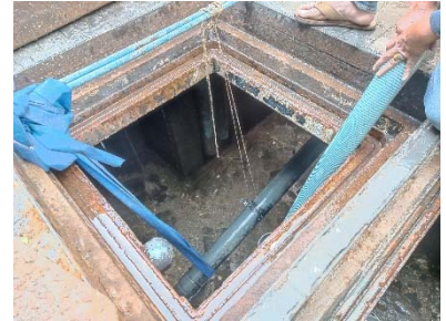
การสูบล้างก่อนจากระบบบำบัดน้ำเสีย
