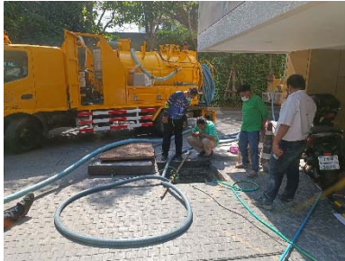
การสูบล้างก่อนจากระบบบำบัดน้ำเสีย
